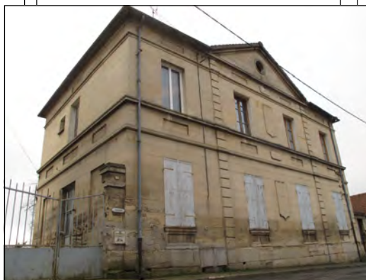
Bâtiment communal pour logements de fonction au 17, rue Béatrix-Tassain.
