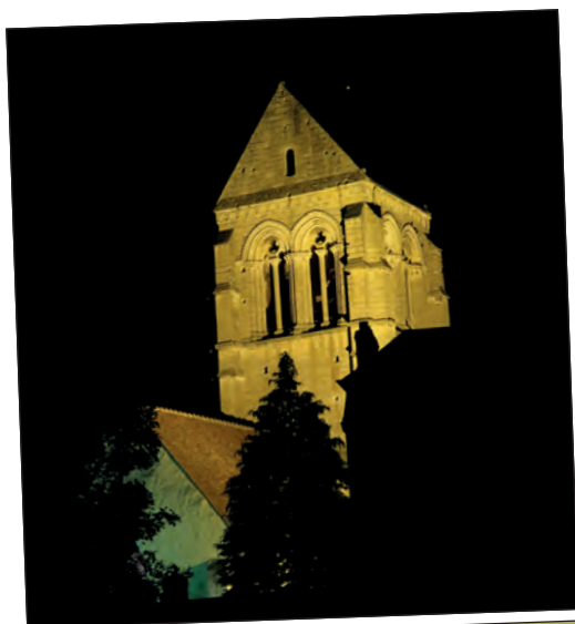
Septembre. Grâce à un nouveau projecteur, toute l'église est maintenant éclairée.
