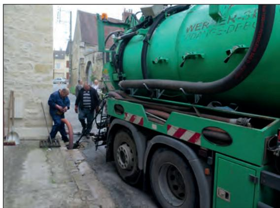
**Avril.** Fin des inondations rue de l'Eglise : une caméra a permis de découvrir qu'un tuyau de gaz traversait la canalisation d'eaux pluviales, ce qui créait un bouchon à chaque orage violent !
