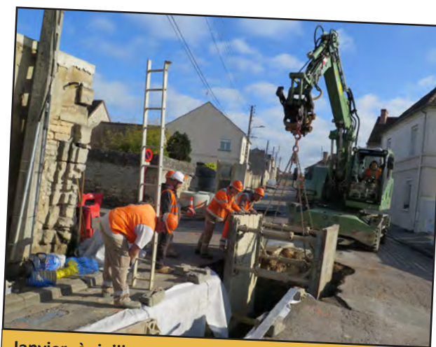
Janvier à juillet. 64 habitations de l'impasse des Acacias, de la rue Roger-Salengro et de la route de Clermont sont raccordées à l'assainissement collectif.
